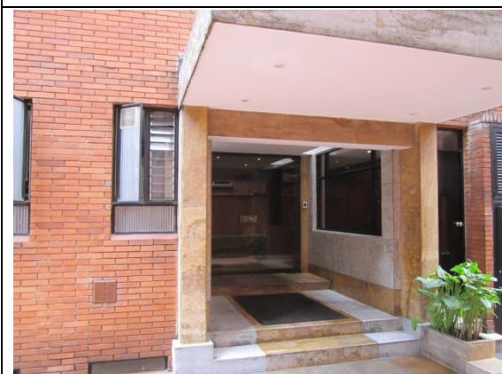
Foto 3. Portería de acceso al edificio.
